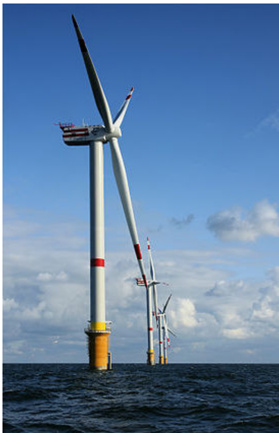
Figura 4 Moderno campo eolico off-shore (installazione su specchio d'acqua) nel Mare del Nord.
